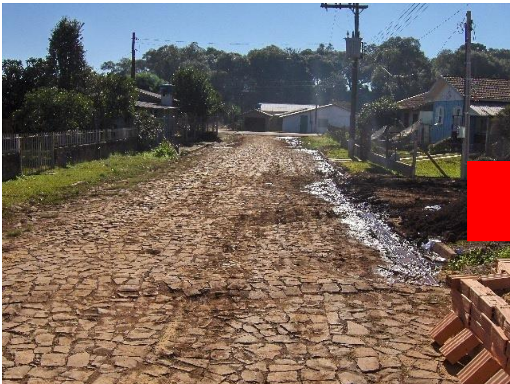
Via a receber reperfilagem com CBUQ
