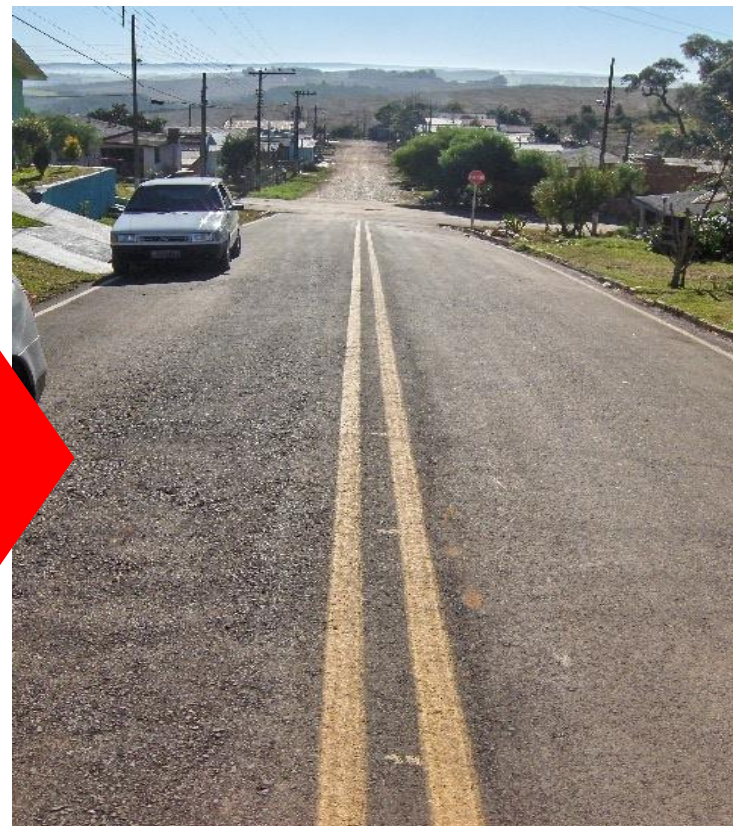
Foi pavimentada outra não prevista
